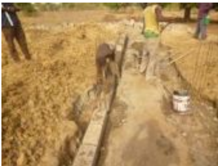
Remplissage des fondations par des briques pleines
